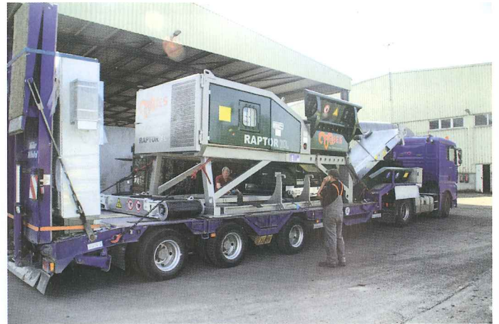
Täglich trifft die neue Technik, Stück für Stück, per Lkw auf der Baustelle in Weißenfels ein. Hier ein Zerkleinerer, welcher den Bioabfall vor der Vergärung in kleine Stücke schreddert.
