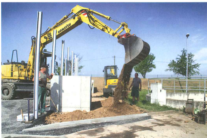
Dort, wo die Fundamente für die neue Halle fertig sind, können die Außenbereiche fertiggestellt werden. Die Lagerkapazität für Astschnitt vergrößert sich mit Fertigstellung der neuen Halle erheblich.
