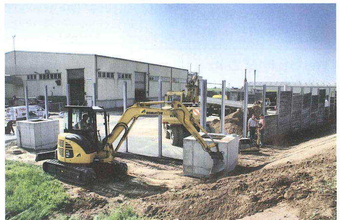
Im Mai liefen die Tiefbauarbeiten und die Vorbereitungsarbeiten zur Errichtung der neuen Halle durch Mitarbeiter der Firma Harbauer auf Hochtouren.
