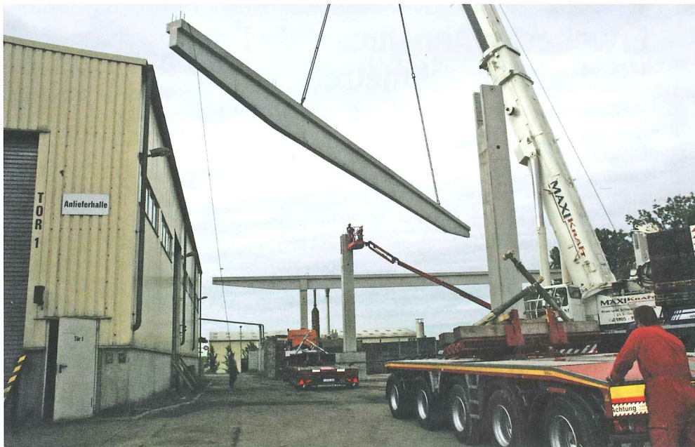
In einer spektakulären Aktion wurden im Juni die mehr als 42 Meter langen und 70 Tonnen schweren Träger für die Hallenkonstruktion durch zwei Hochleistungskräne gesetzt.
