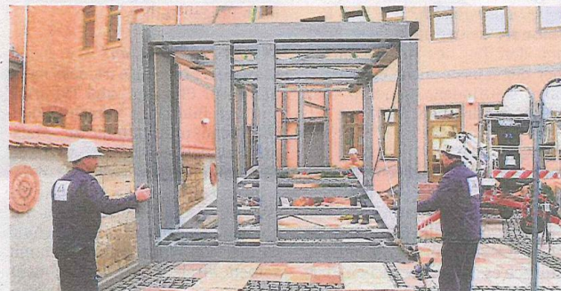
Der Aufzug wird an die Hinterseite des Erweiterungskomplexes der „Alten Schmiede“ angebaut. Um 18 Zimmer vergrößert das Hotel sein Angebot.
