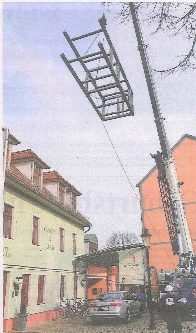
2,1 Tonnen sind die Teile schwer, die der Kran vors Haus transportiert. Kurzzeitig musste der Lindenring für den Verkehr gesperrt werden. FOTOS: T. BIEL
